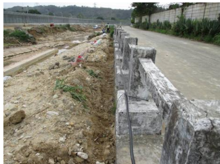
照片 6 临时排水沟 (4)
