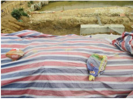
照片 1 彩条布临时覆盖 (1)
