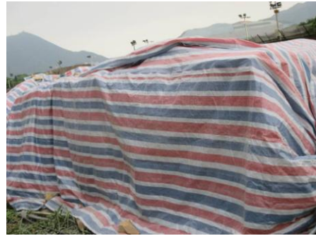
照片 2 彩条布临时覆盖 (2)
