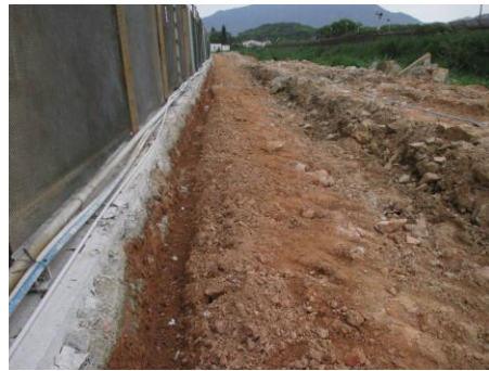
照片 4 临时排水沟 (2)
