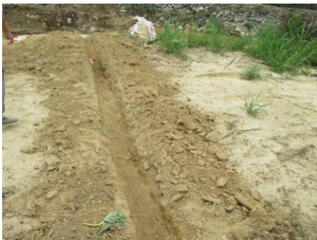
照片 5 临时排水沟 (3)
