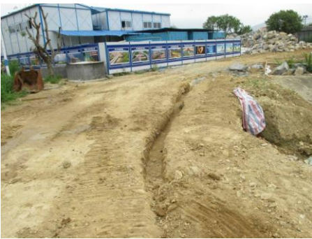
照片 3 临时排水沟 (1)
