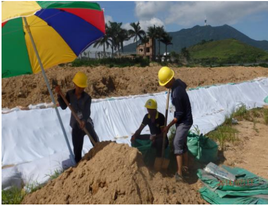
照片 3 合同 B 导流渠土工布砂袋压脚
