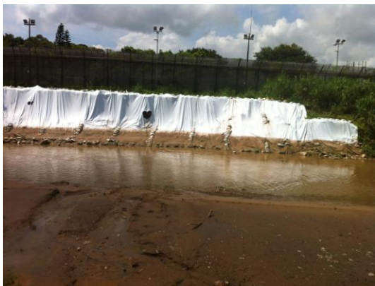
照片1 合同A南岸土工布防护
