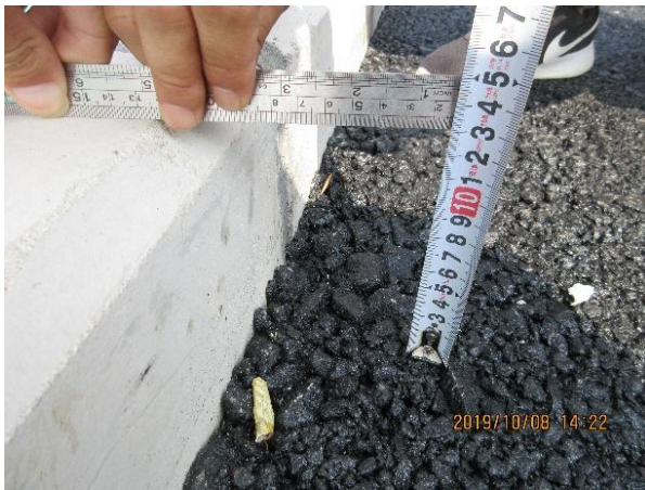
图 8 南澳河综合整治工程路缘石表面与沥青下面层高差不符合设计要求（设计要求 19cm，现场实测最小处 13cm）。
