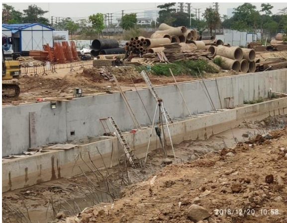
图 13 2018 年 12 月 20 日，茅洲河流域中上游段支流（玉田河）综合整治工程桩号 YTH0+133 处工人清除。
