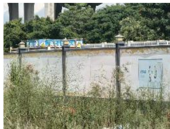
图5 大空港新城区截流河综合治理工程-主体部分（不含生态修复）北枢纽大门最左侧围挡无公益广告。
