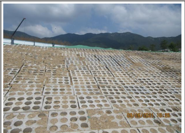
图3 坝光片区防洪(潮)排涝工程第III标段上新屋水入海口预制多孔砖拼装缝隙过大。
