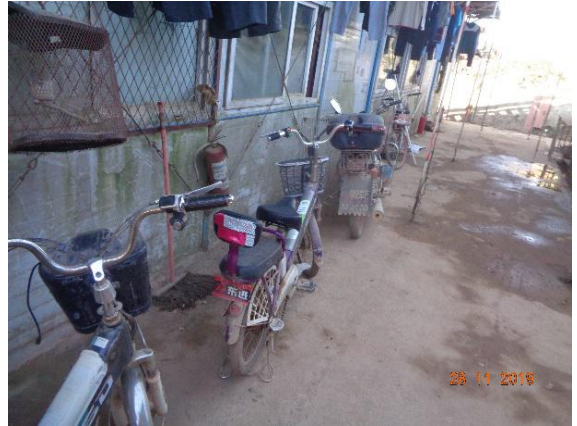
图 11 深圳市清林径引水调蓄工程水库库底清理工程电瓶车未设置集中充电点、存放区。
