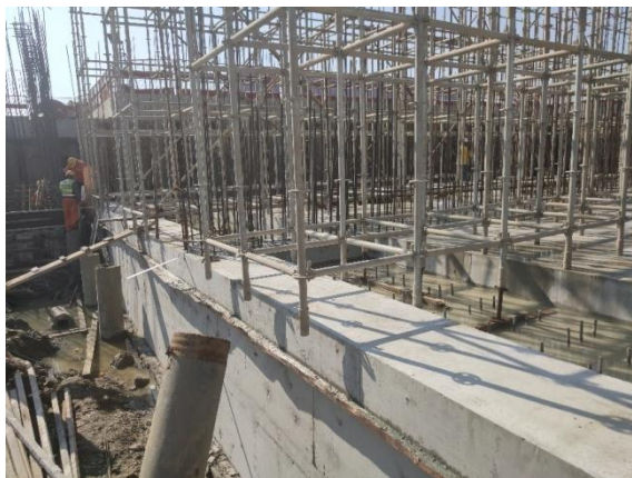
图 12 大空港新城区截流河综合治理工程-主体部分（不含生态修复）部分立杆悬空。
