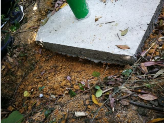
图 6 三洲田水库一级水源保护区 3 号坝至侨城段隔离围网工程围网立柱基础尺寸未达到设计要求（设计尺寸设计为 600x600x800mm）。
