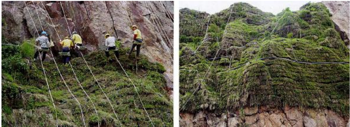
图 8 挂笼砖的施工图示
