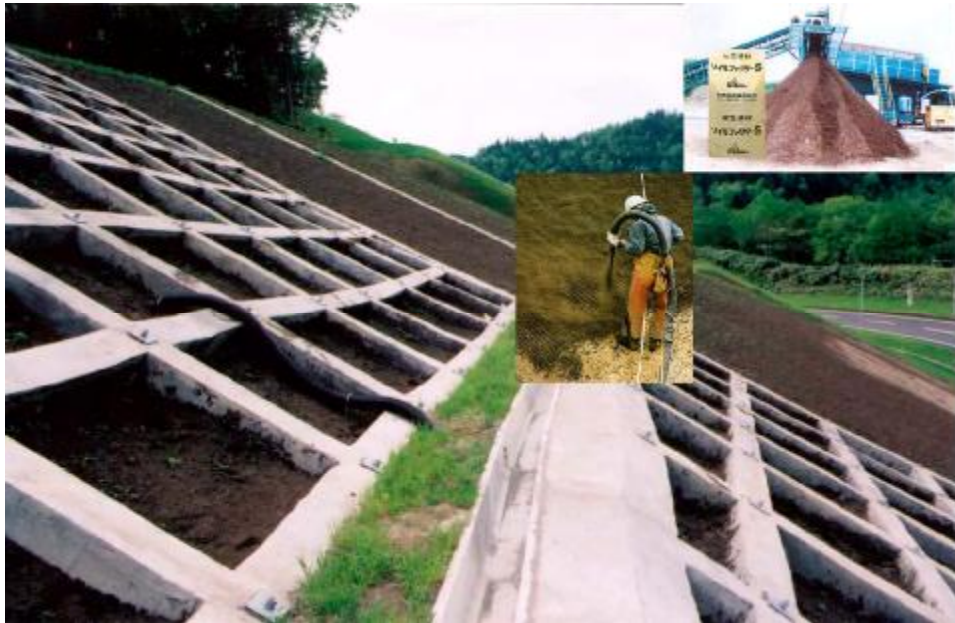
图 2 种子喷播技术的施工图示
