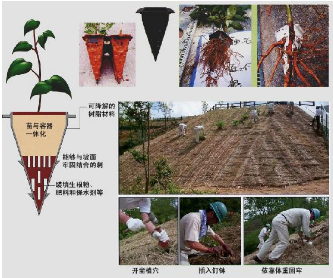
图 10 钉钵苗栽植技术的施工图示
