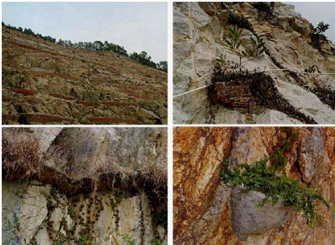
图 7 植生盆的施工图示
