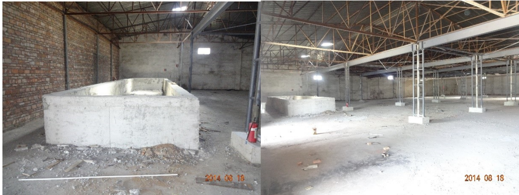
污染土封闭式无害化处理车间
