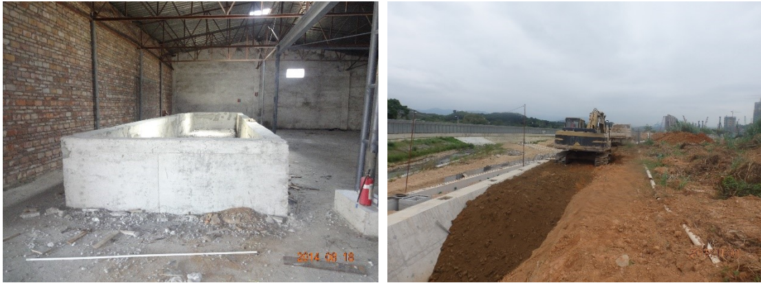
污染土固化处理厂及污染土固化无害化回填
