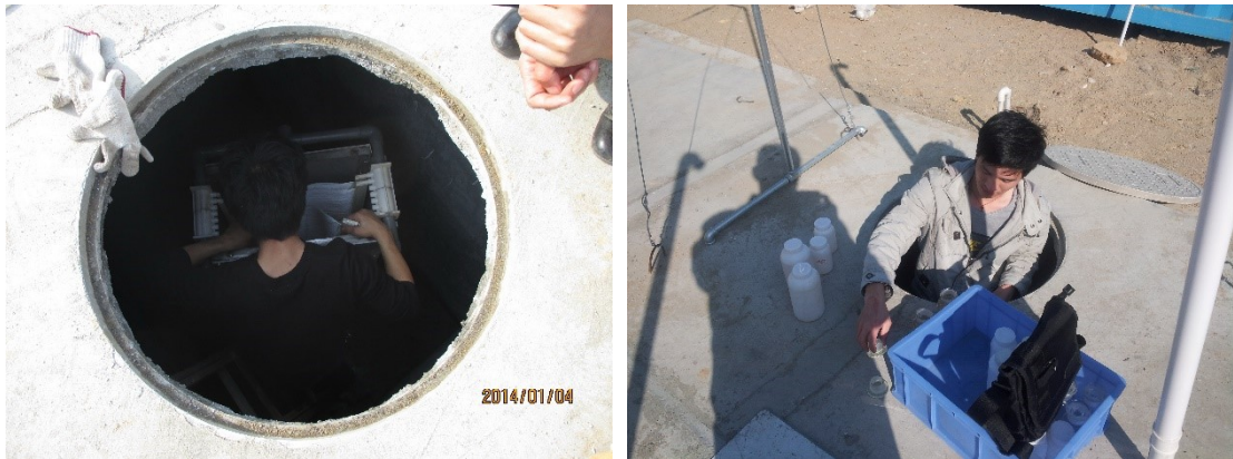
污水处理设备安装调试及采样
