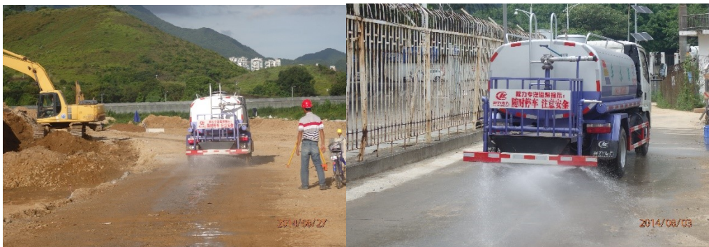
施工路段洒水降尘
